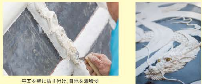
平瓦を壁に貼り付け、目を漆喰で海に「なまこ」のように盛り上げた「なまこ壁」
